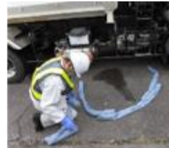
フェンスで流出防止
