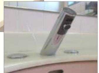
・蛇口タイプからセンサータイプの自動水栓へ切換え（6箇所）
